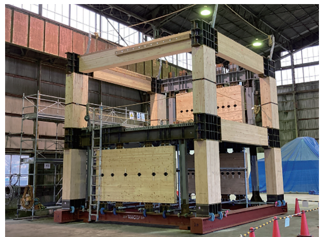
写真一1 実現した開発構法の木造躯体
