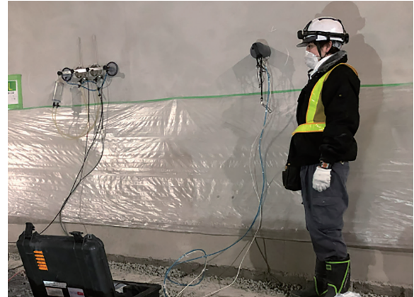
写真-6 表層品質試験状況 (トンネル現場 C)
