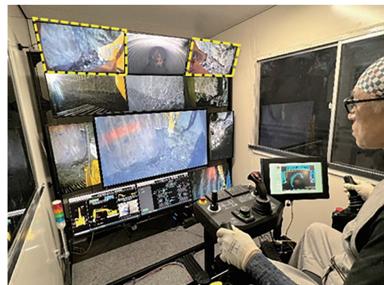
写真-10 遠隔操作によるあたり取り（改良後）
