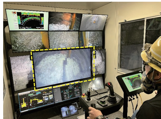
写真-8 遠隔操作によるあたり取り（改良前）
