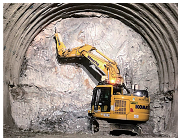
写真－7 遠隔操作中の油圧ブレーカ
