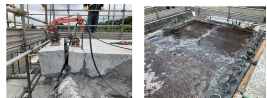
写真-4 実験状況（左：破断状況、右：破断完了）
