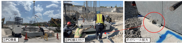
写真－2 PC 据え付け状況
