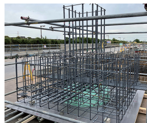
写真-1 配筋状況
