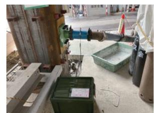
写真-2 圧送配管接続状況
