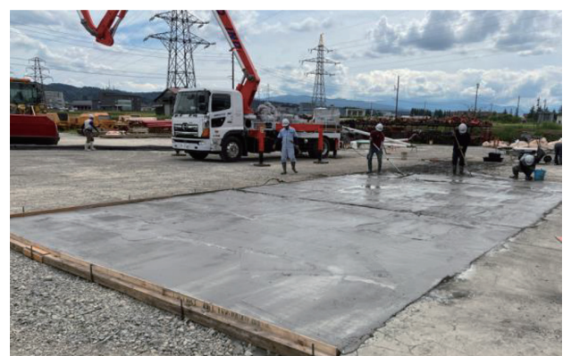
写真-4 土間仕上げ状況
