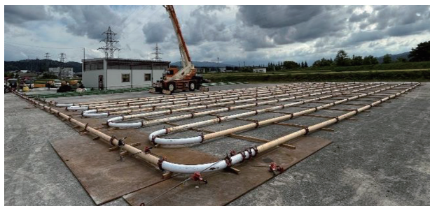
写真－1 長距離圧送施工試験配管状況
