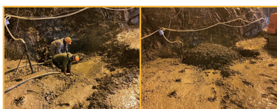
写真-4 コンクリートプラグ実施状況
