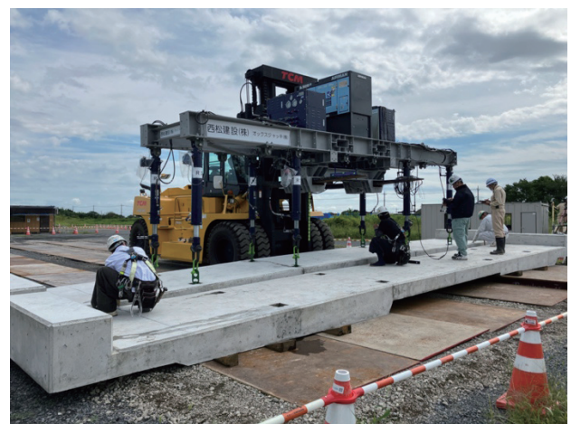
図一3 実大実験状況（運搬，設置）
