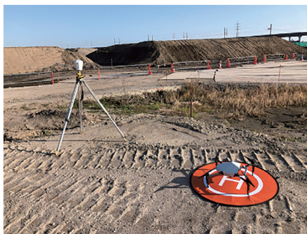
写真-1 土量測量に使用した UAV
