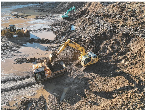
図一 遠隔操作状況（積み込み）
