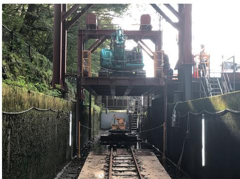
写真-2 昇降架台設備
