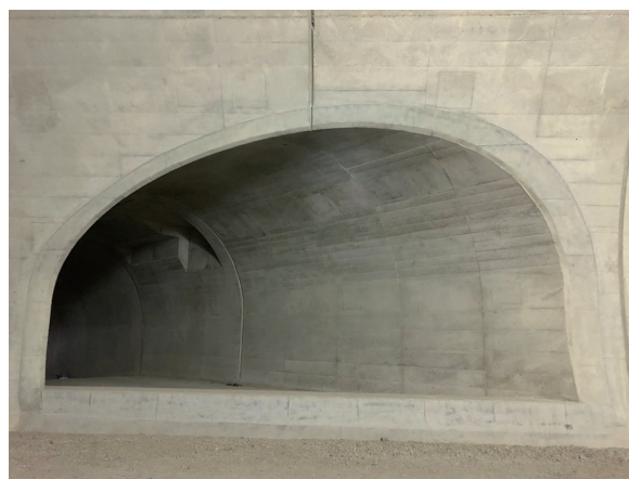
写真一 打設完了状況
