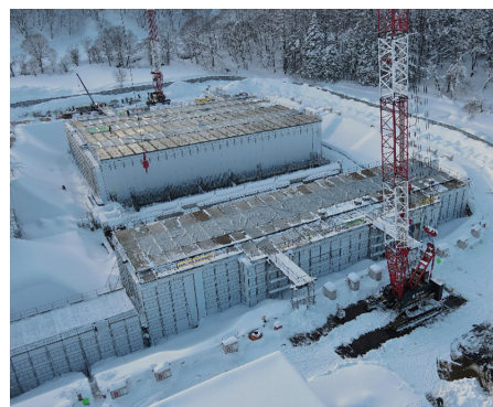
写真一3 冬期施工全景
