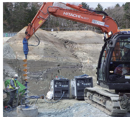
写真二2 杭内部掘削状況
