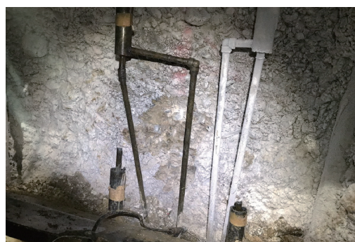
写真一2 凍結管のバイパスライン設置状況
