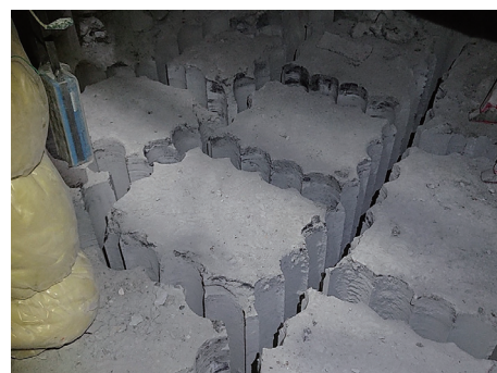
写真一1 コア抜きによる底版コンクリート撤去
