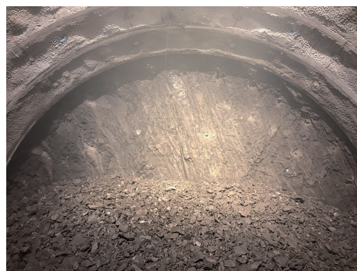
図一2 自動削孔で孔尻を揃えて発破した切羽
