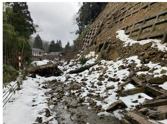
写真一3 県道 26 号法枠部の被災状況
