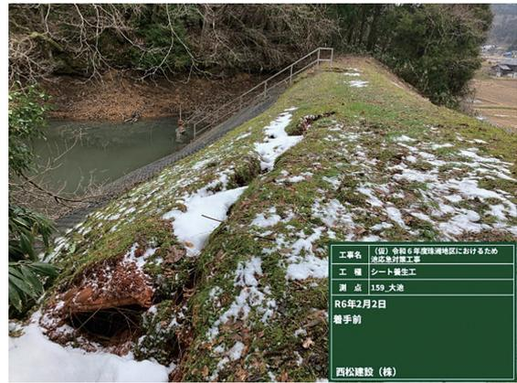
写真一5 ため池の損傷状況
