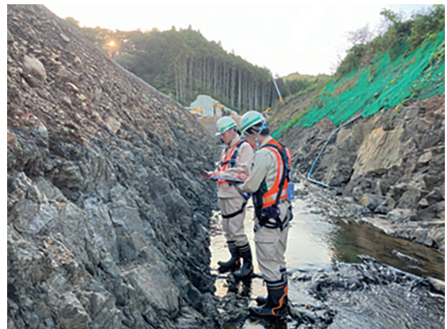
写真－6 定量的な岩盤評価手法を活用した施工時の岩盤確認
