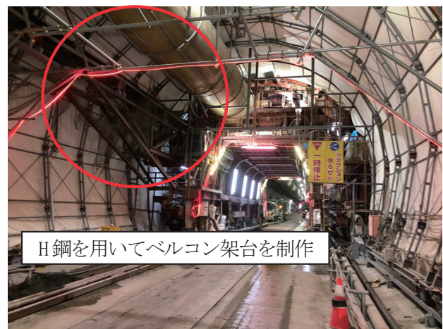
図-13 セントル台車後方ベルコン架
