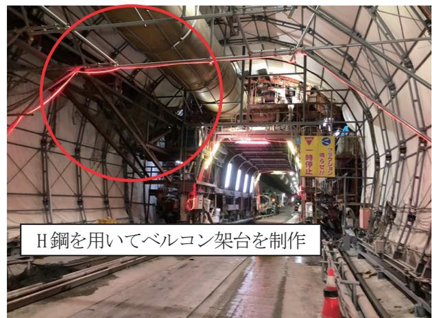
図-13 セントル台車後方ベルコン架
