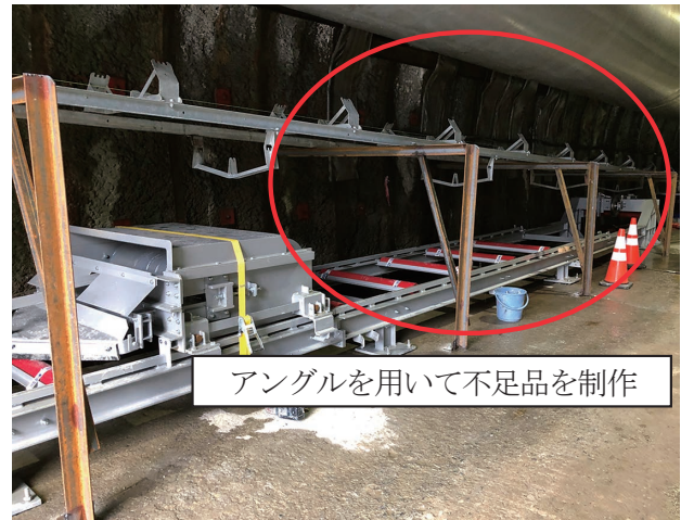
図-12 不足品の現場製作
