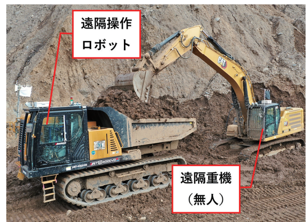
図-1 重機の遠隔施工状況
