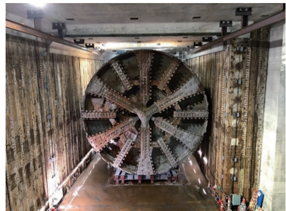
写真-3 シールドマシン押し出し完了
