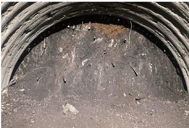
写真-3 188 km 846 m 切羽の土砂化
