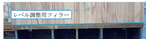
写真-9 レベルの調整方法
