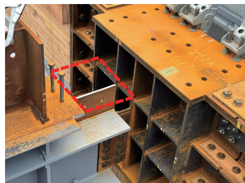
写真ー5 カットTの分割状況
