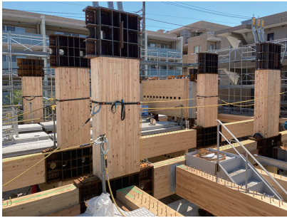
写真－7 柱・耐力壁建て込み状況
