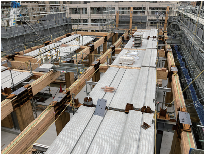
写真－6 スパンクリート設置状況
