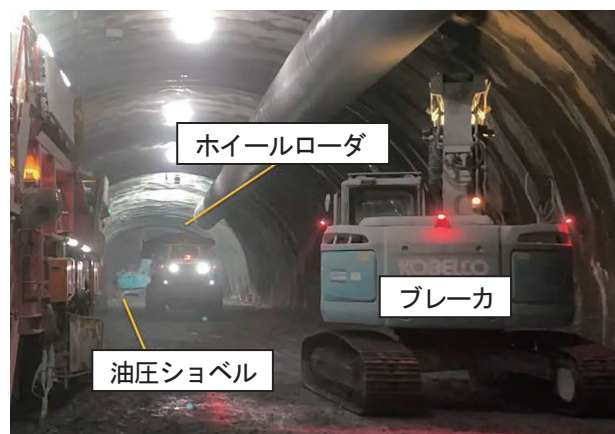
写真ー2 複数重機によるずり出し作業状況
