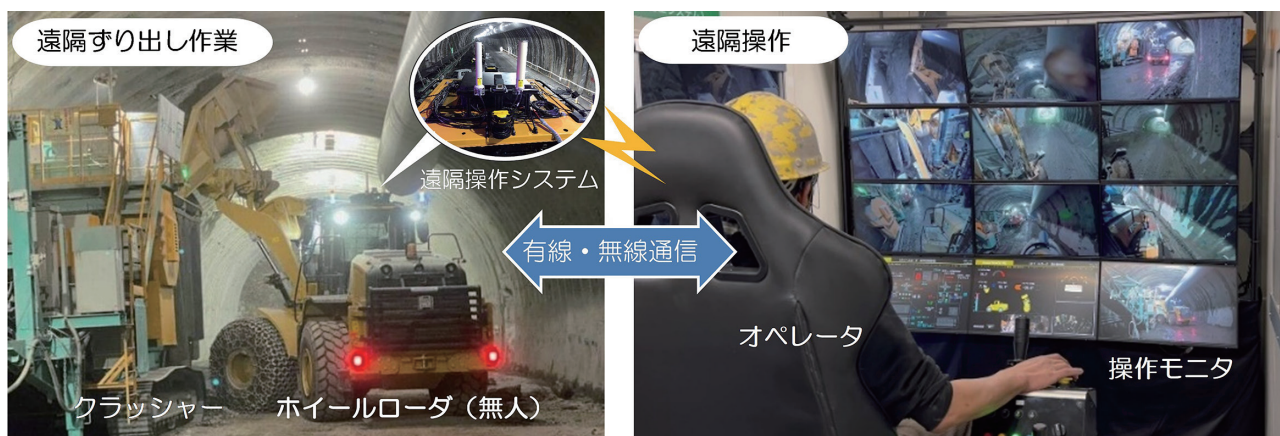
写真一7 ホイールローダ遠隔操作システム（実用機）によるずり出し作業状況
