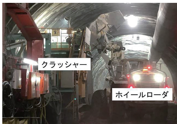
写真ー1 ホイールローダによるずり出し作業状況
