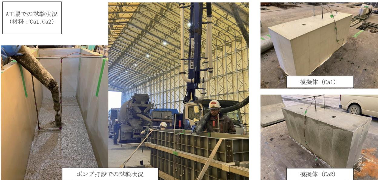
図-10 実施工を想定したコンクリートポンプ車での試験状況 (A 工場)
