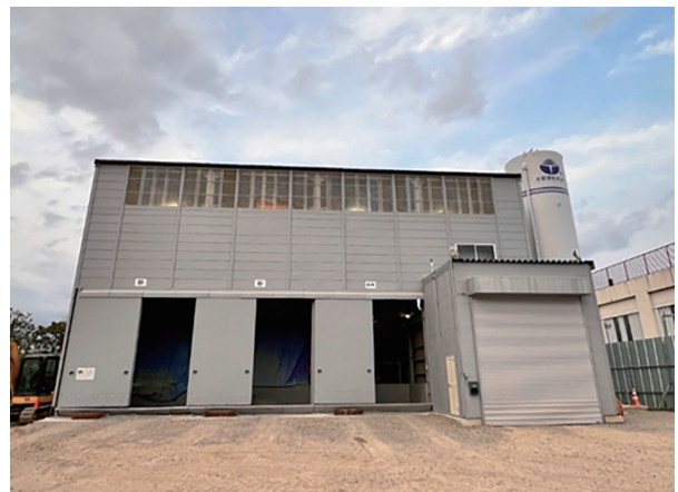
写真－1 バッチャープラント
