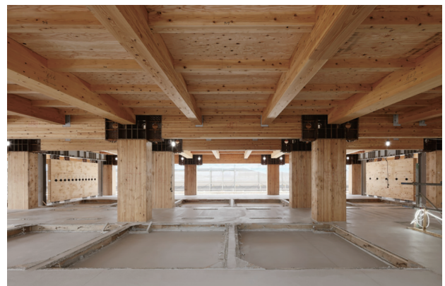
写真-1 実現した開発構法の木造躯体
