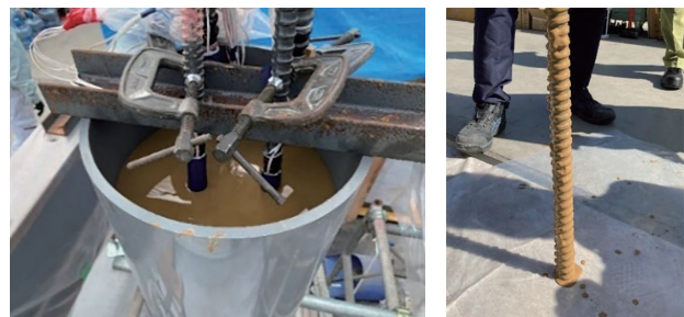
写真一 鉄筋表面への安定液の付着状況
