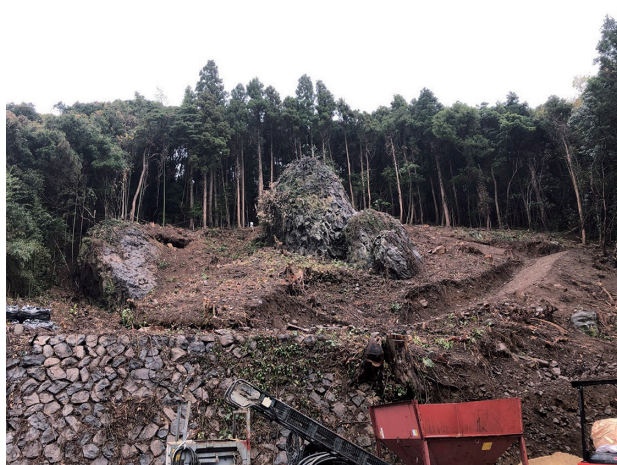
写真-1 玄武岩岩塊の露頭状況
