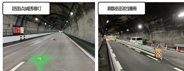
写真-2 路面点滅誘導灯、鋼製仮設防護柵
