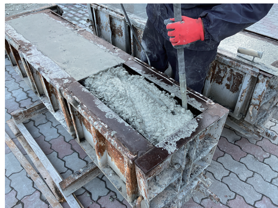
写真二 二次製品製作状況
