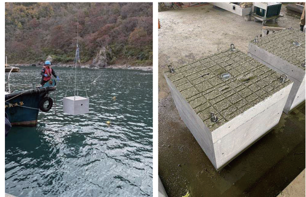
写真-4 藻場ブロック沈設の様子
