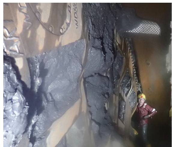
写真－2 閉塞した開口部
