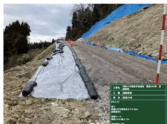
写真一2 県道26号 復旧後
