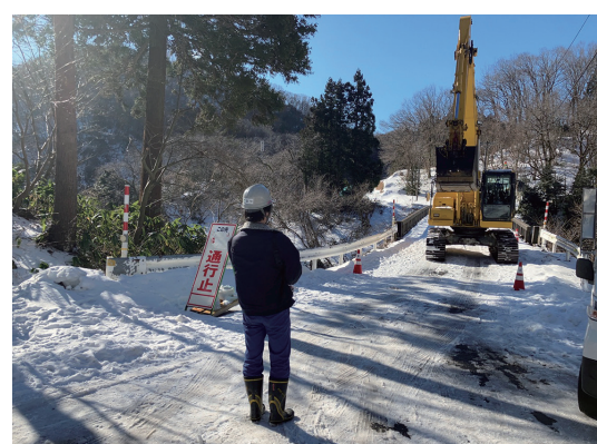
写真一4 遠隔操作状況
