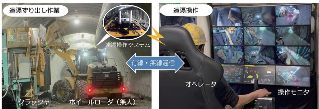
写真-1 ホイールローダ遠隔操作システム(実用機)によるずり出し状況
