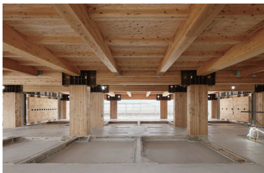
写真ー1 実現した開発構法の木造躯体
