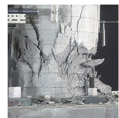
写真一2 試験体の 最終破壊状況
