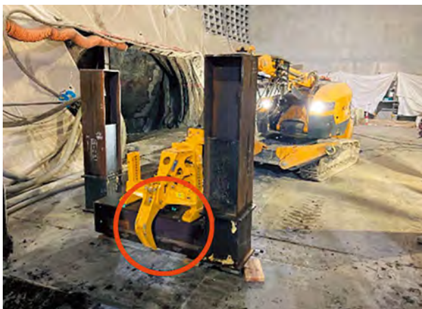
写真-13 鋼製支保工把持状態
