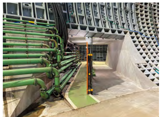
写真-14 躯体打設完了
