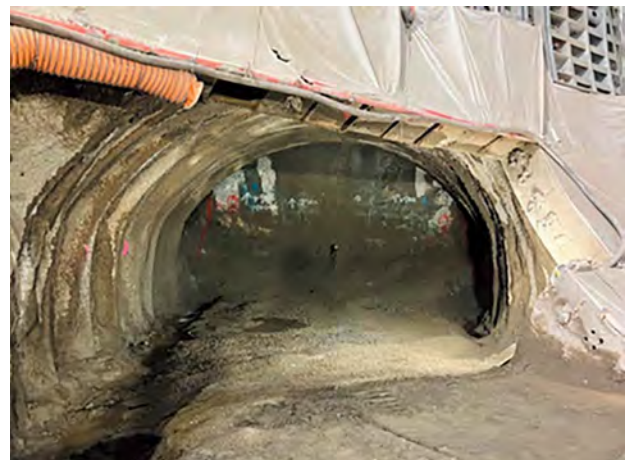
写真―9 仮支保工設置完了
