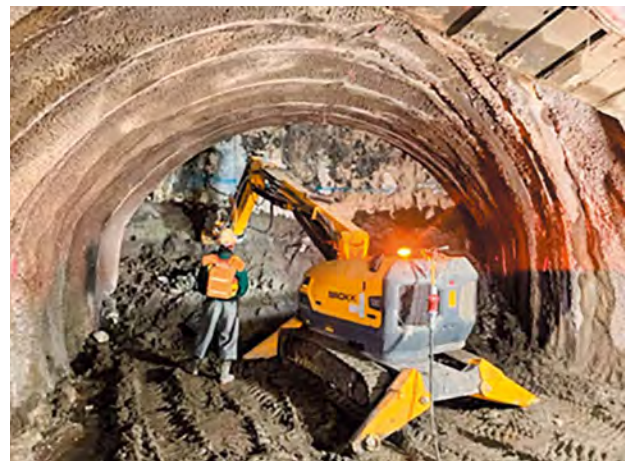
写真―8 仮支保工断面掘削状況
