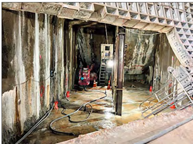
写真一11 上下半本支保工設置完了
