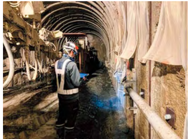
写真－10 1人での内空変位計測作業状況
