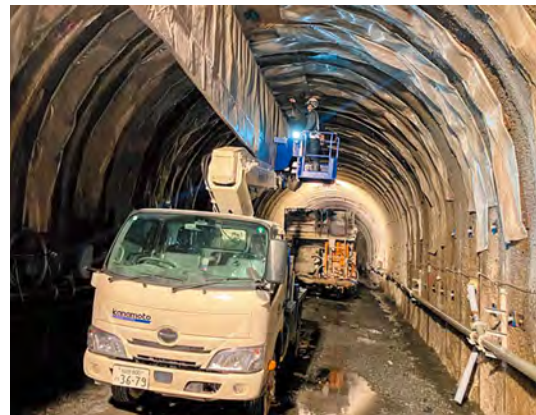
写真-7 従来プリズム設置状況
