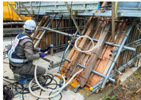
写真-4 真空処理の状況（施工面A）
