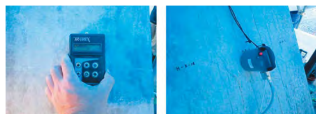
写真一7 表層透気係数測定状況 (左：含水率測定 右：表層透気係数測定)
