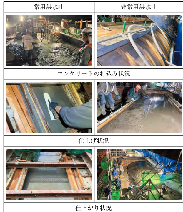
写真一10 真空パネル工法の適用状況
