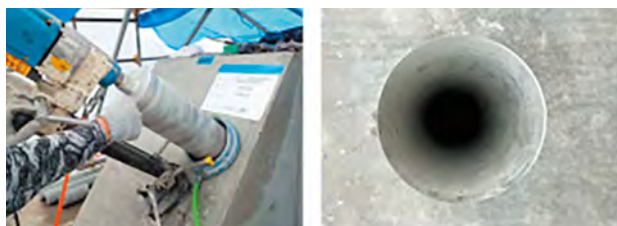
写真一 8 コア供試体採取状況 (左：コア供試体採取 右：コア供試体引き抜き後)
