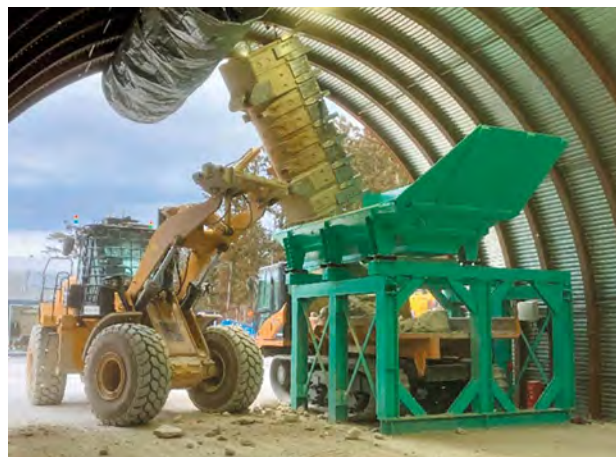
図ー10 自動化ホイールローダのずり投入状況
