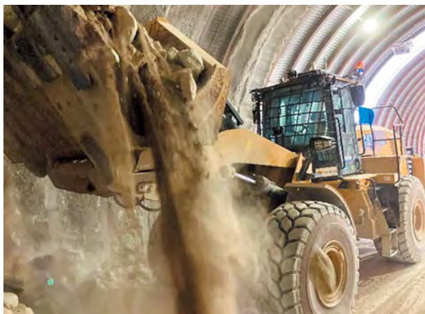
図ー9 自動化ホイールローダのずり回収状況
