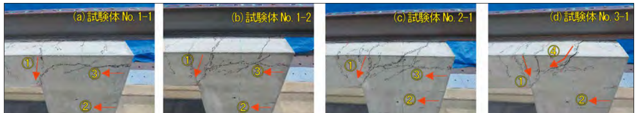
写真一三 各試験体の隅角部の最終破壊状況
