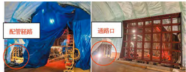
写真一1 35BL 打設状況と妻枠組立後
