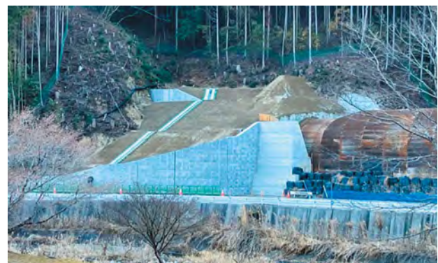
写真ー2 施工後（一部未施工）
