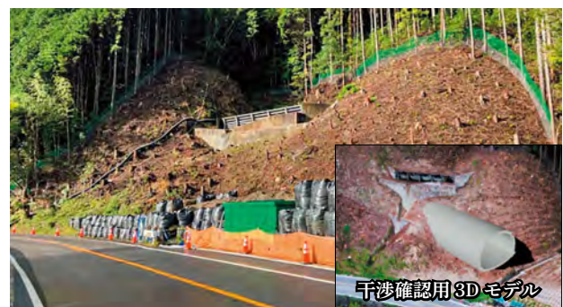
写真ー1 施工前
