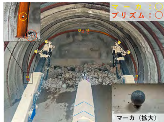
写真-2 マーカおよびプリズム設置位置
