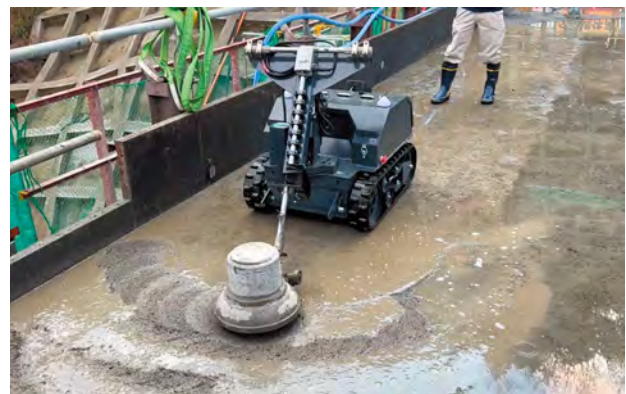
図-4 ダム現場での試験施工
