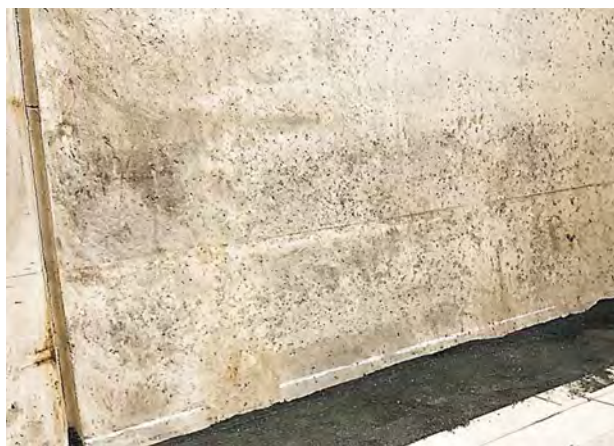
写真-1 覆工コンクリート下半部での表面気泡発生例
