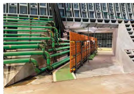
写真二 施工完了
