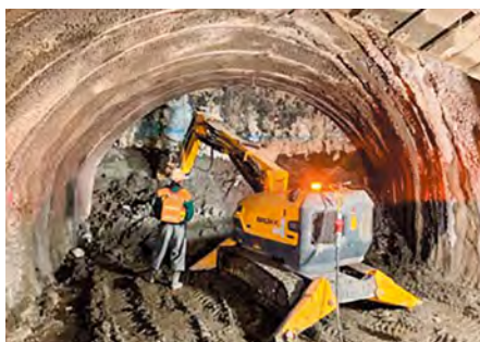
写真一 施工状況
