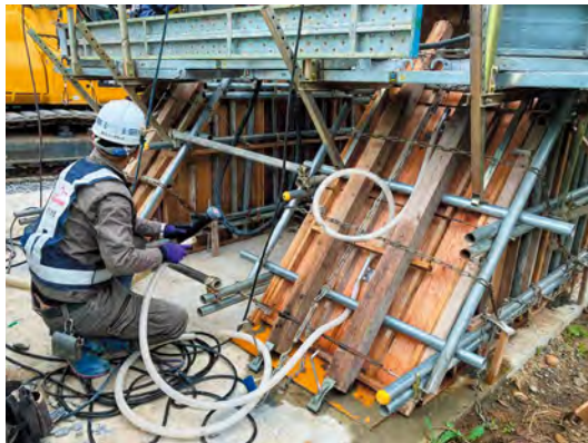
写真一 真空パネル工法の適用状況
