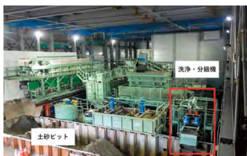
写真-1 現場泥水処理プラントの全景
